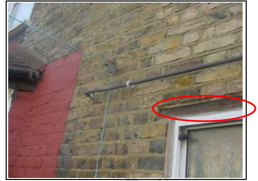
Timber lintel above the patio door
