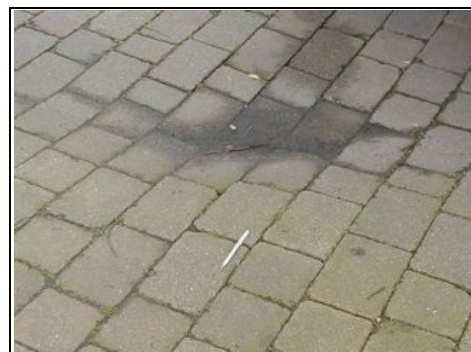
Sunken pavia slabs
